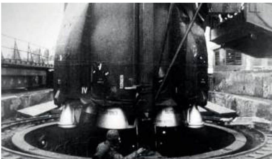
Установка ракеты Р-36орб в ШПУ
