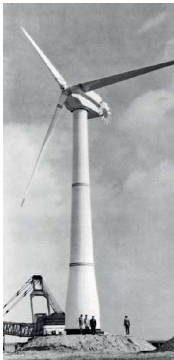
Первый ветроэнергетический агрегат АЭВ-100А, разработанный в КБ «Южное» и изготовленный на Южмаше
