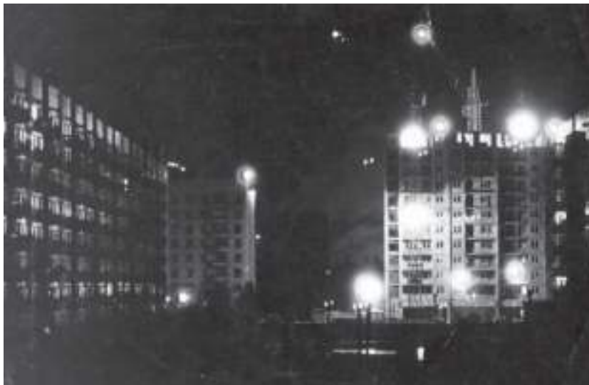
Строительство жилья не прекращалось и ночью
