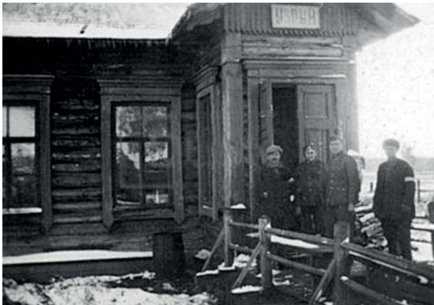
Станция Узруй, конец 1941 года
